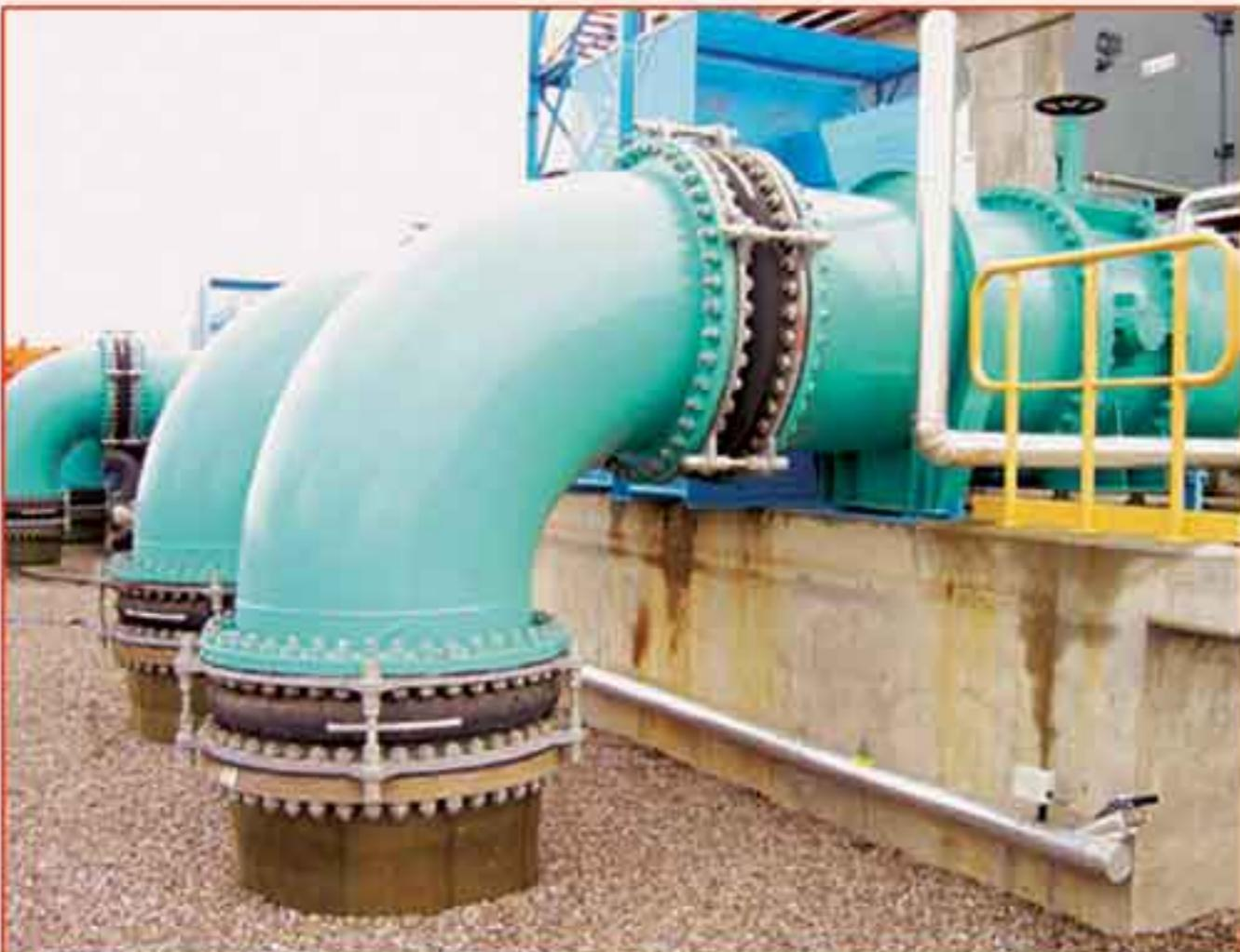
لرزه گیرهای لاستیکی عمدتاً جهت دفع لرزش ناشی از کارکرد تجهیزات مکانیکی نظیر پمپ ها، کمپرسورها، فن ها و ... مورد استفاده قرار می گیرند.
