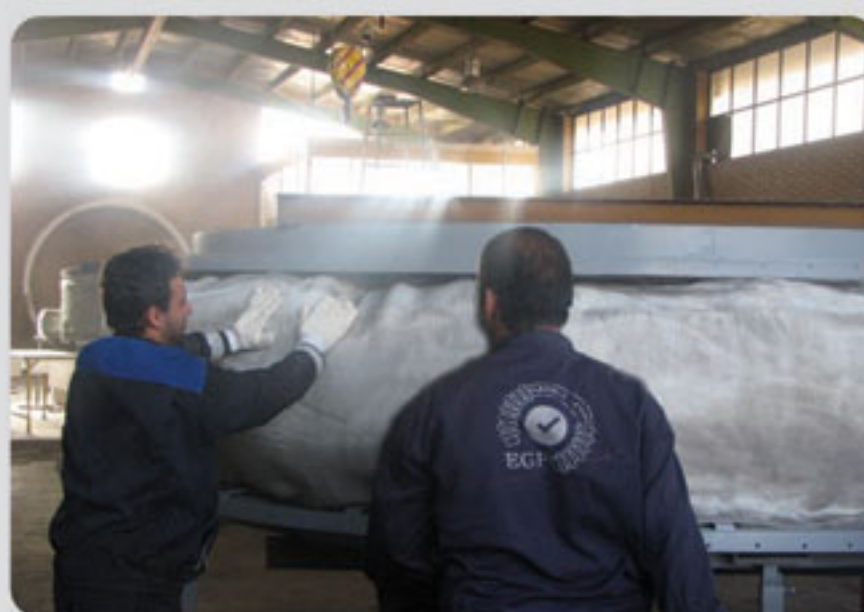
نصب عایق برروی فریم <
